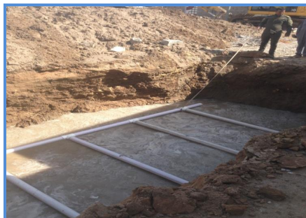
Рис 2. Изготовление и монтаж грунто-воздушного теплообменника
